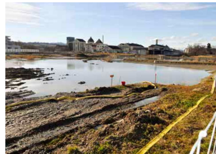
Dieser Teil des Radunerareals in Horn ist bereits von Altlasten befreit worden. Die Arealfläche der Reto Peterhans AG (Hintergrund) ist noch kontaminiert.
